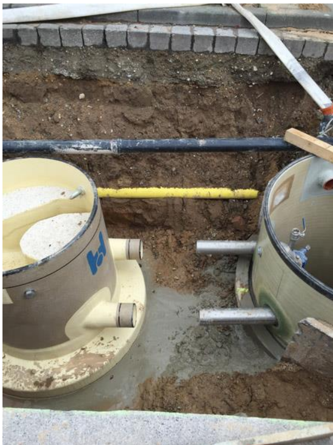
Vorbereitung des Druckentlastungsschachtes für den Anschluss an das Pumpwerk
