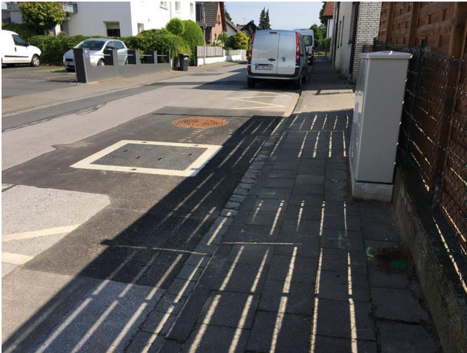
Die Baustelle in der Klappertorstraße nach der Sanierung. Rechts der neue Schaltschrank für die Steuerung des Pumpwerks.
