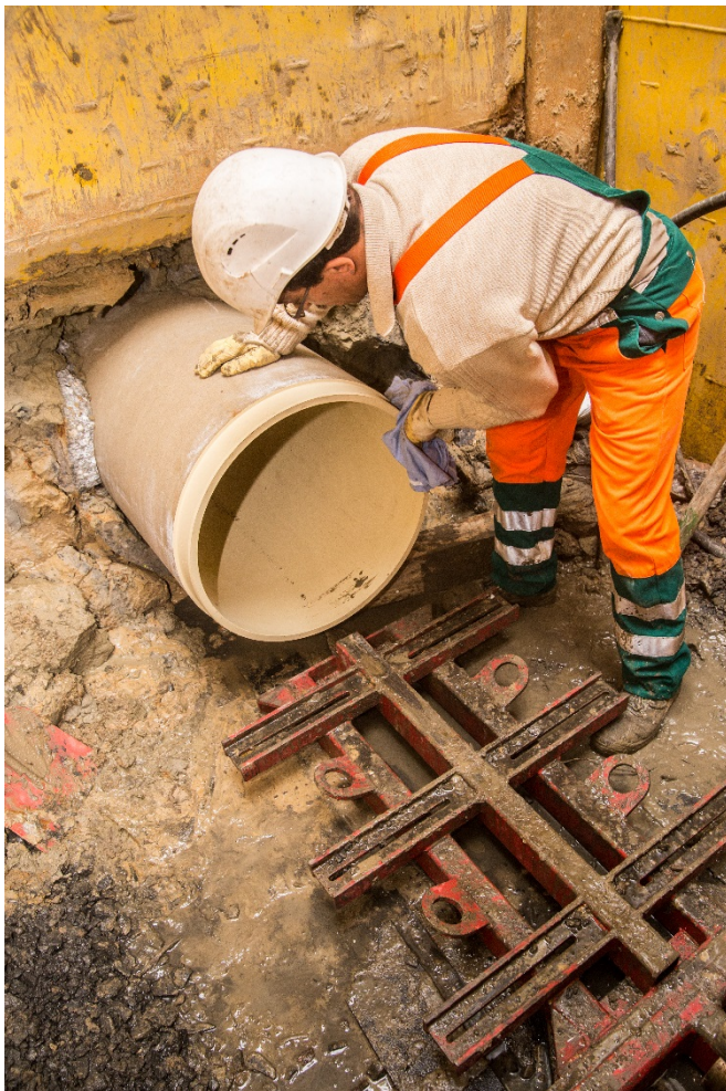
Bild 1: Erneuerung eines Regenwasserkanals im Berstverfahren
