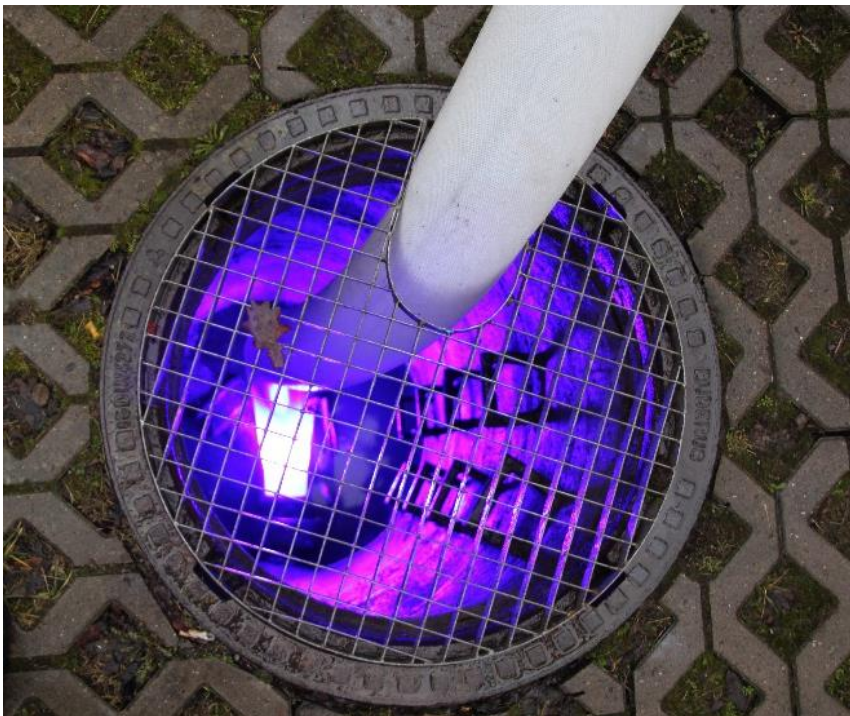
Bild 2: Aushärtung eines Schlauchliners mit der Bluelight-LED-Technik
