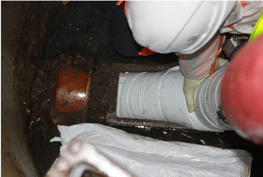
Bild 1: Inversion des F-Liners aus einem Revisionschacht heraus
