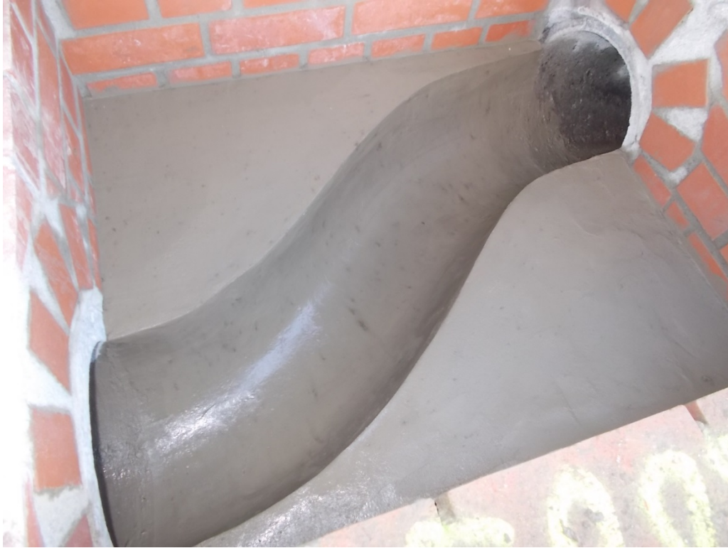
Bild 3: Praxisbeispiel - Neu aufgebautes Sohlgerinne in einem Mauerwerks-Schacht
