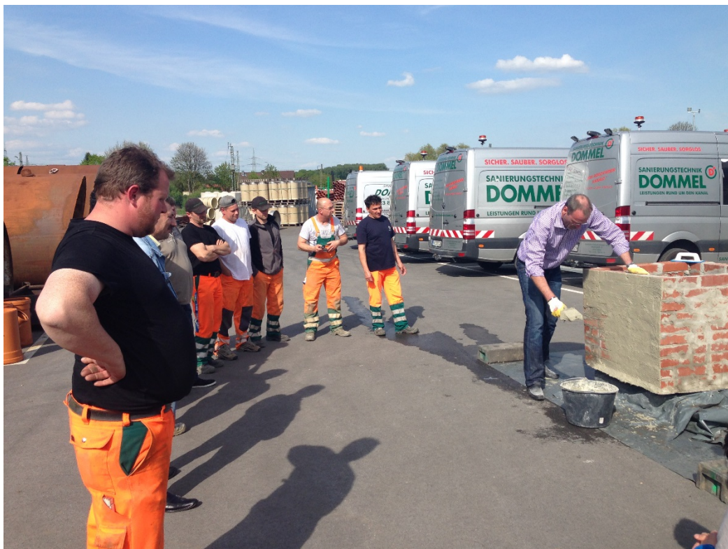
Bild 1: Praktische Vorführung der Dichtschlämme Mapei Idrosilex Pronto zur Abdichtung von Mauerwerk
