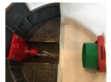
Die Anwendung von Einschweißsatteln ermöglicht die grabenlose Zulaufanbindung.
